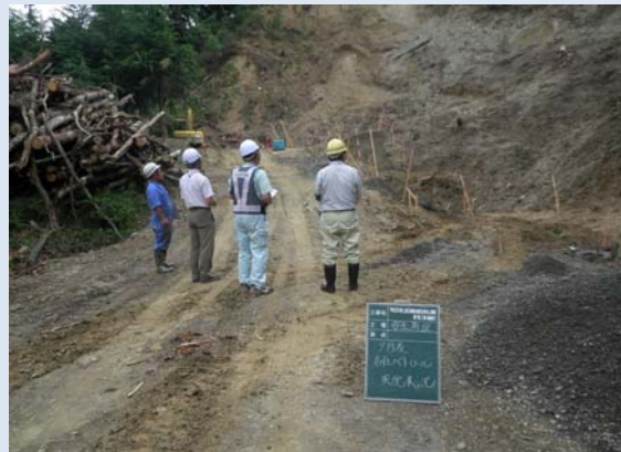
2班 土木工事の巡視
