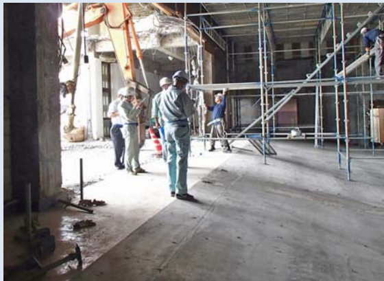
1班 建築工事の巡視
